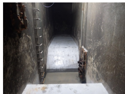
④ 流出渠底盤完成
