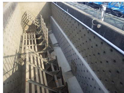
① 整流壁完成
