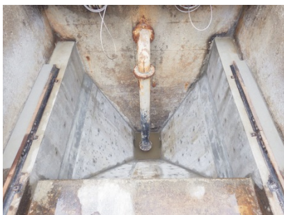
③ ピット完成
