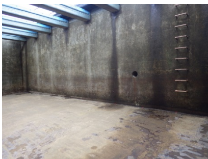
② 流出渠壁着手前
