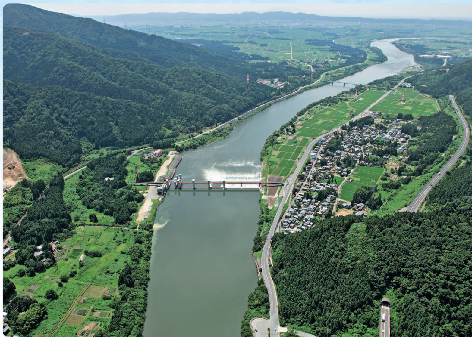
頭首工を上流から下流を望む
