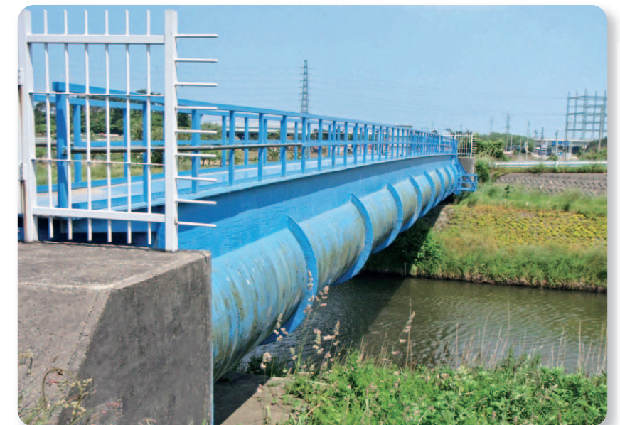
導水管(水管橋)
