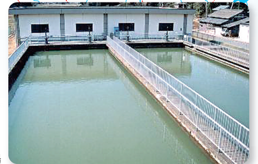
沢口導水ポンプ場
