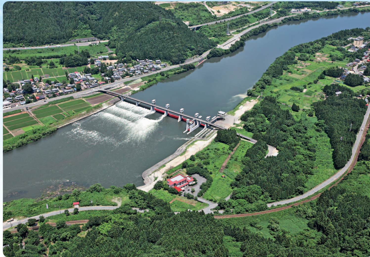
阿賀野川頭首工
