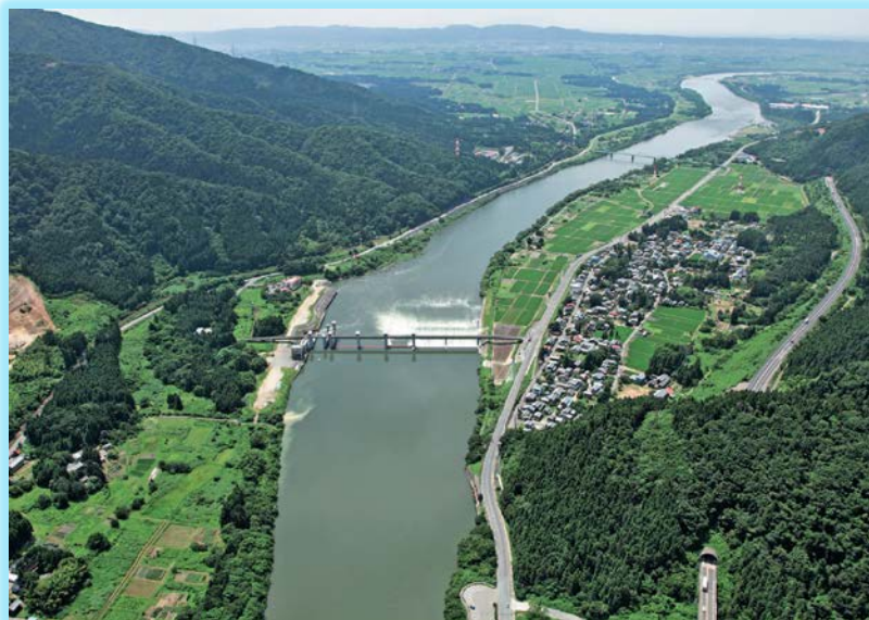
阿賀野川頭首工上流から下流を望む
