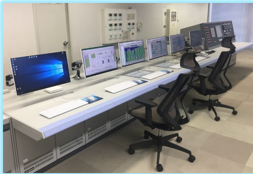
東港浄水場中央監視室 監視制御装置(令和元年度更新)
