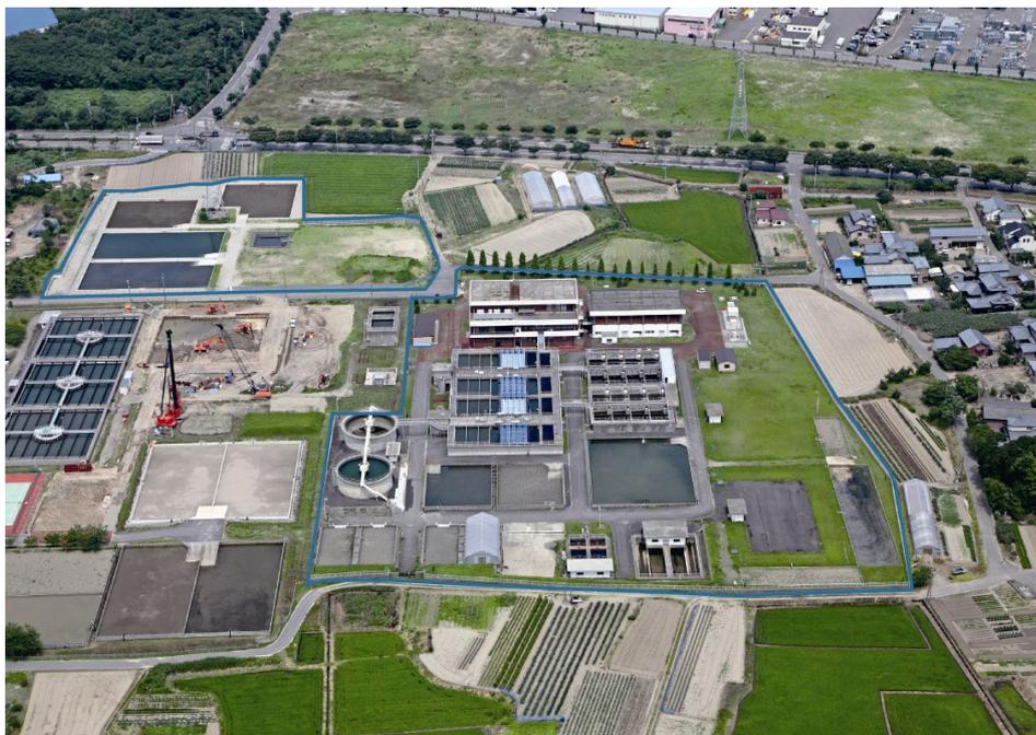
企業団の水道用水供給事業は、一級河川阿賀野川(頭首工)から一日最大82,100m<sup>3</sup>を取水し、東港浄水場で浄水した後、一日最大75,450m<sup>3</sup>(施設能力)の水道用水を、総延長26.9kmの送水管を経て、企業団を構成する2市1町(新潟市、新発田市、聖籠町)及び1簡易水道事業者(明和工業㈱)の調整池(7ヵ所)に供給しています。
