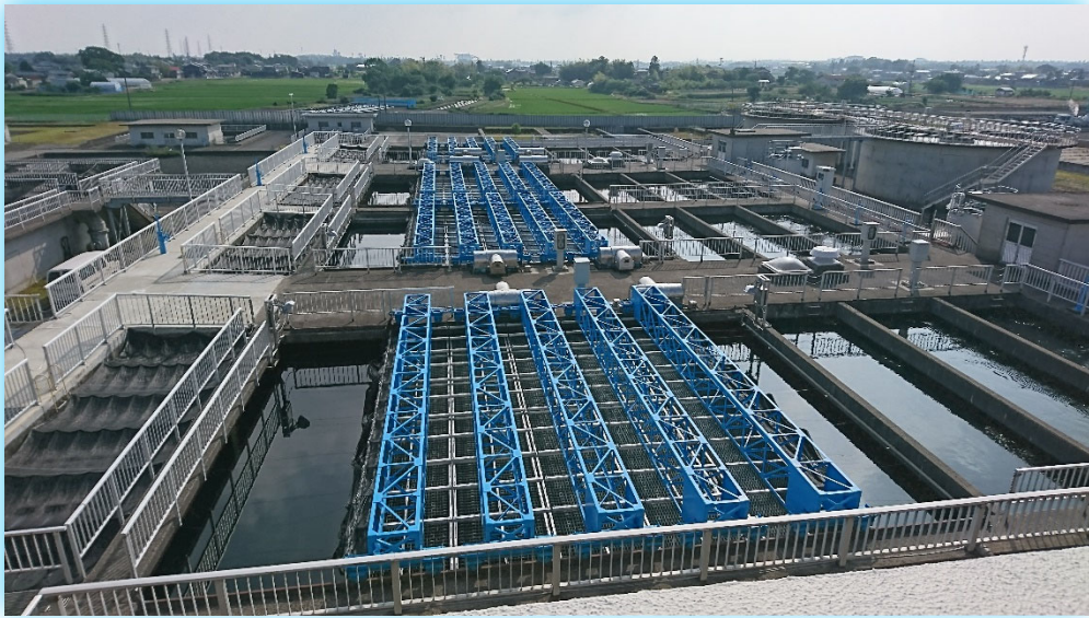
東港浄水場沈でん池
