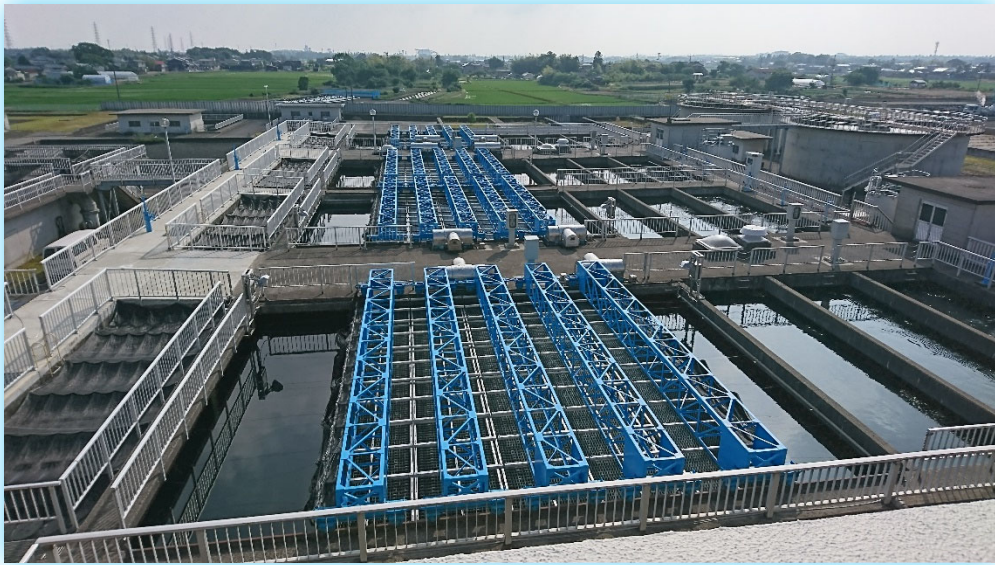
東港浄水場沈でん池
