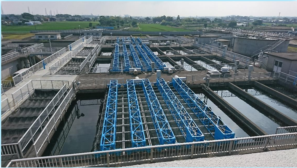
東港浄水場沈でん池
